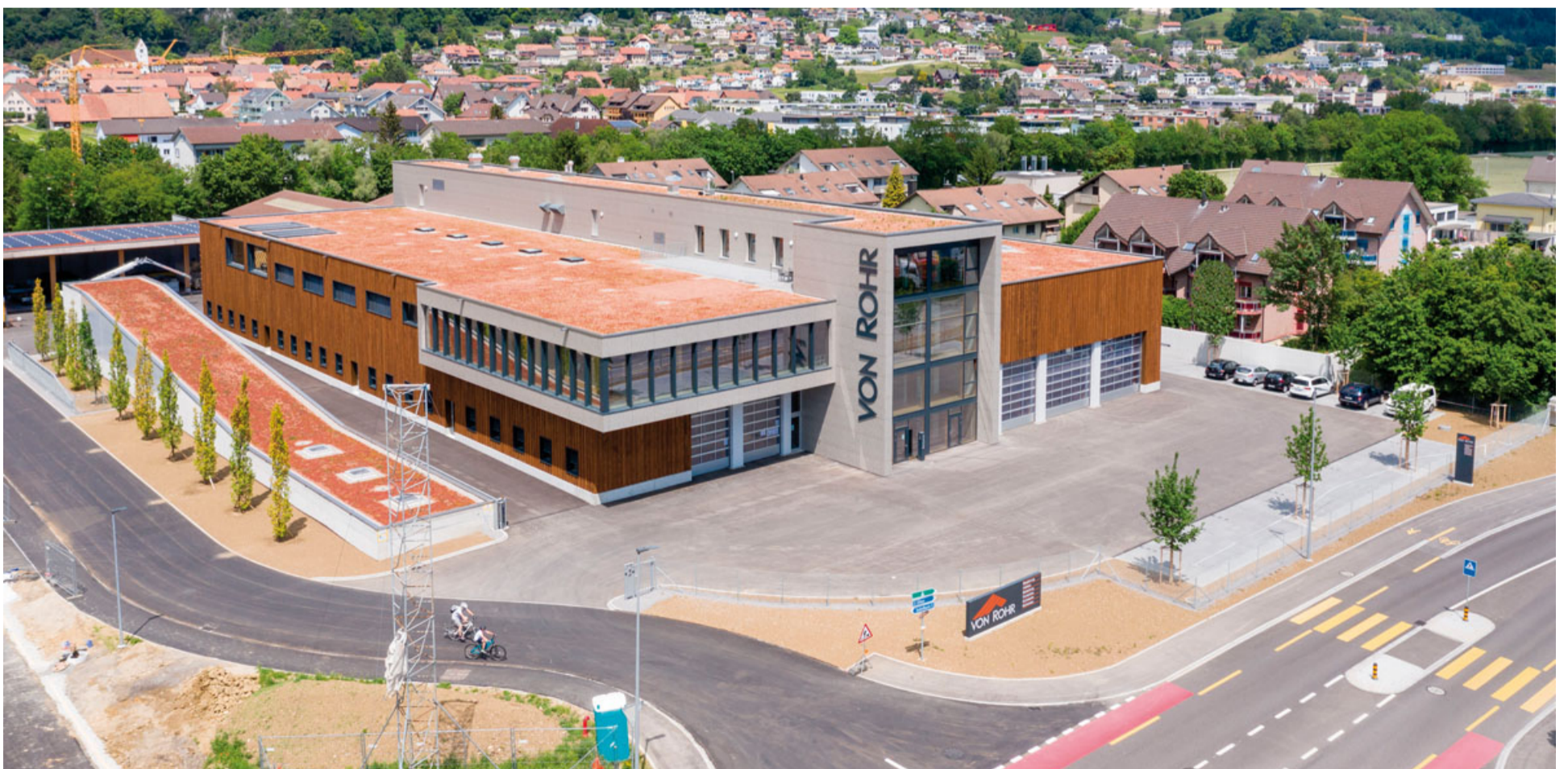
Neues Betriebsgebäude der von Rohr Holzbau AG an der Bifangstrasse in Egerkingen.
