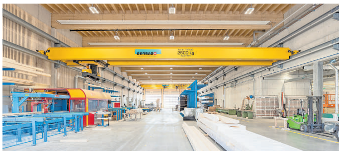
Die Holzbauhalle bietet genügend Platz für eine grosszügige Elementherstellung
